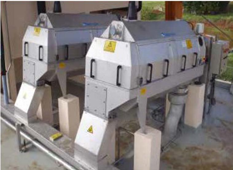
*Tamiz rotativo Roto-Sieve, modelo RS-24, instalado en Guadalupe, planta de tratamiento para la protección de las membranas de ultrafiltración.*
