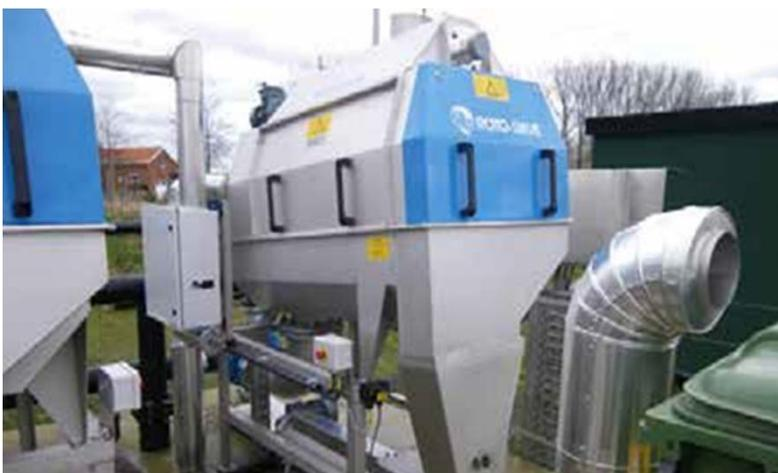
*Tamiz rotativo Roto-Sieve RS-22, instalado en Zwalm planta de tratamiento para la protección de las membranas de ultrafiltración*
