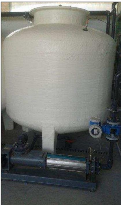
El depósito de alimentación de osmosis inversa está equipado con un sistema de corrección del valor del pH con el fin de acondicionar el producto antes de entrar en las membranas de osmosis.
