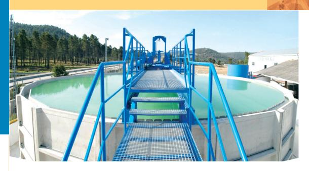
La Cabeza de Mando consiste en un fuerte grupo reductor de corona y tornillo apoyando la corona sobre un gran anillo periférico de rodadura a bolas y el tornillo en cojinetes de rodillos. El conjunto funciona sumergido en baños de aceite.
